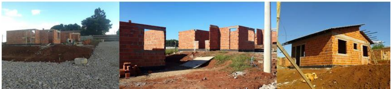
Figura 2: HIS em construção no loteamento Canaã, Passo Fundo, RS, Brasil
