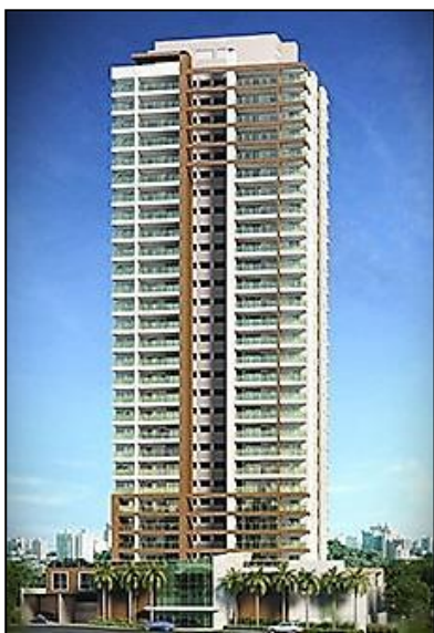
Figura 1 - Empreendimento com torre única e 27 pavimentos.
