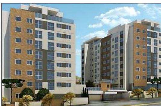
Figura 2 - empreendimento com duas torres e 7 pavimentos.
