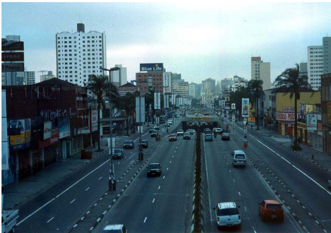
Foto 2, Av Perimetral, trecho em calha rebaixada
