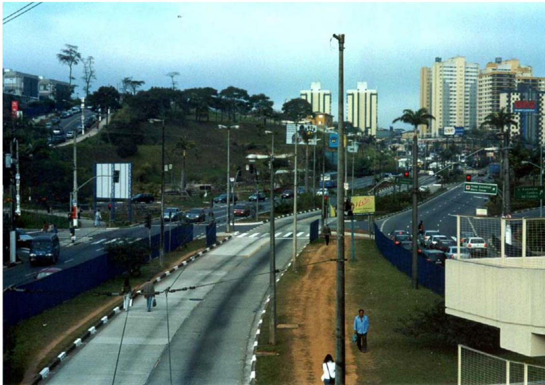
Foto 4 , Av Ramiro Colleoni, vista em direção ao Centro
