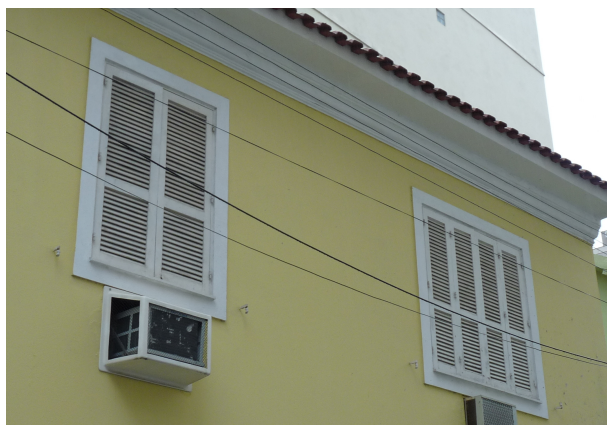
Figura 20 – Janelas de abrir: quase a totalidade (100%) do vão na fachada é aproveitada para ventilação.
