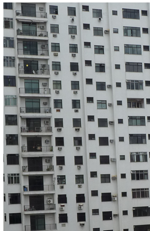
Figura 19 – Profusão de janelas de correr: fachadas com apenas metade da ventilação possível.
