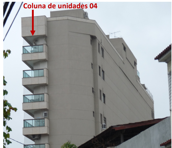
Figura 16 – Detalhe de vista lateral das unidades 04 e fundos de edificação residencial em terreno estreito. Notar a grande parte cega da fachada posterior, colada na divisa do terreno, trecho dos corredores. Fonte: Acervo pessoal
