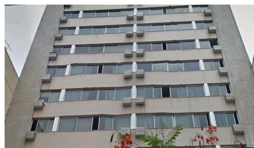
Figura 19 – Profusão de janelas de correr: fachadas com apenas metade da ventilação possível.
