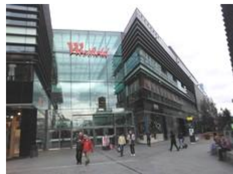
Figura 7 – Acesso rua externa/interior.
