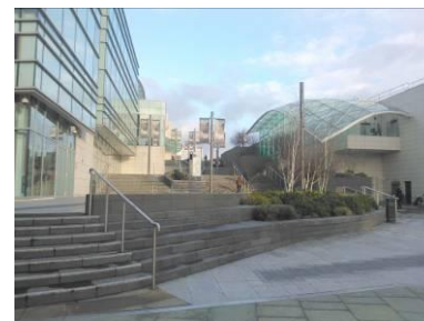
Figura 31: Acesso à rua aberta.
