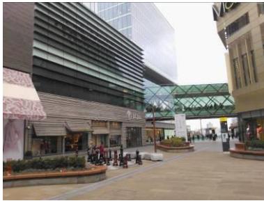
Figura 26: Passarela do metrô.
