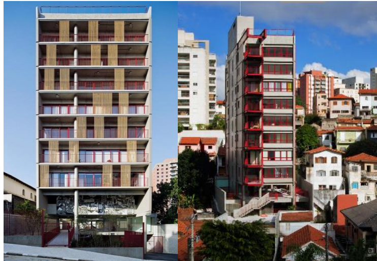
Figura 3 Vistas do edifício Simpatia 236 A: fachada da rua Simpatia . B: fachada da Medeiros de Albuquerque . Fonte: Grupo SP (2007)
