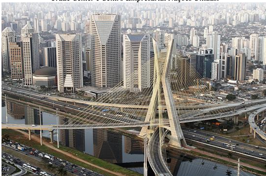
Figura 4: Ponte Octávio Frias de Oliveira tendo ao Fundo os conjuntos World Trade Center e Centro Empresarial Nações Unidas.
