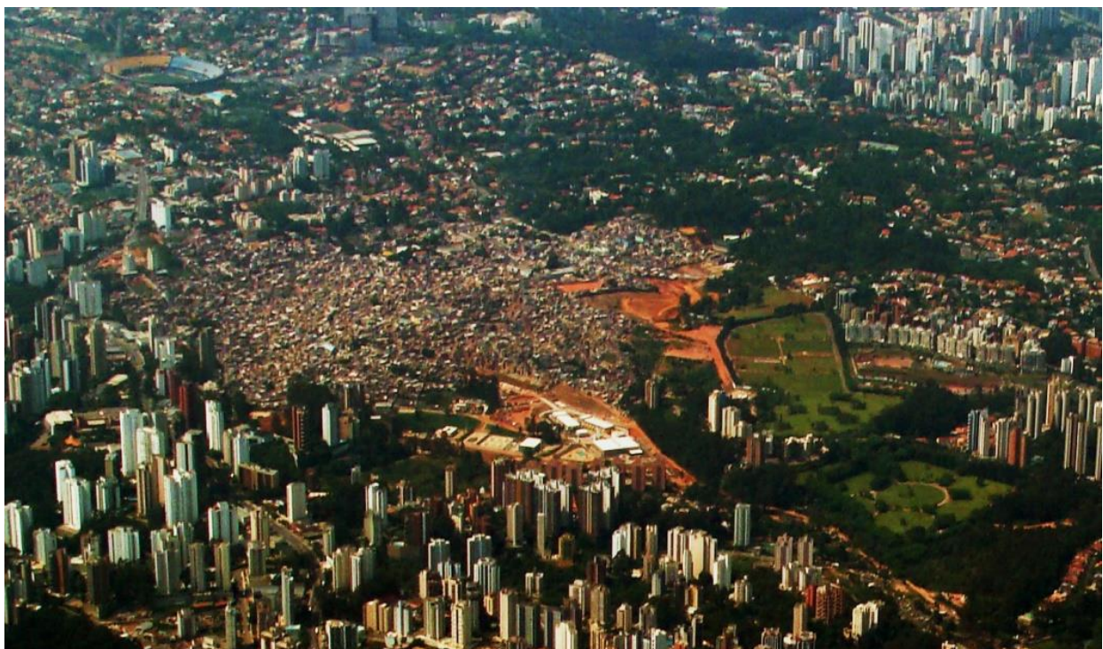
Figura 2 – Paraisópolis em obras, quando da construção da avenida perimetral
